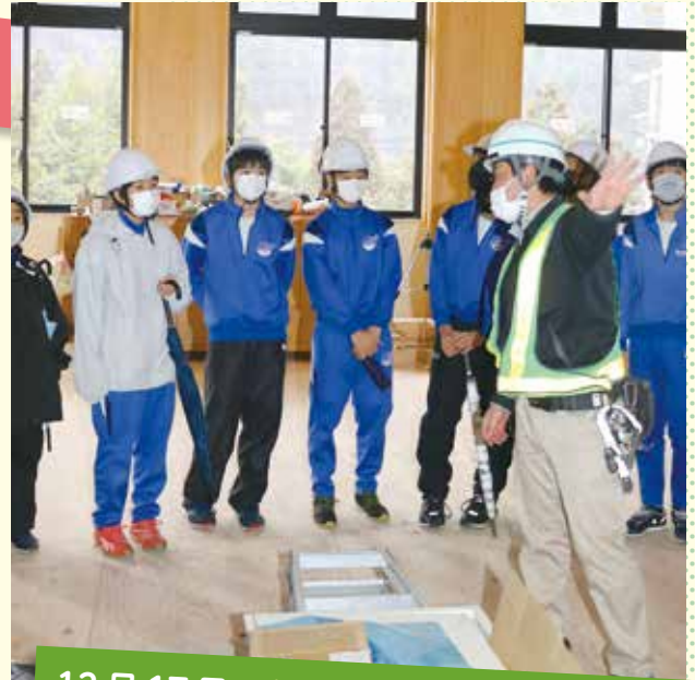
12月17日 中学校 役場新庁舎建設現場見学
