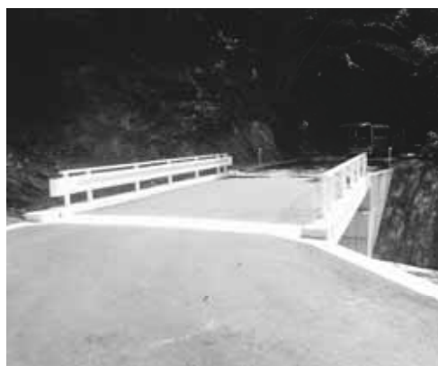
▲林道松淵深沢線 猿沢1号橋
