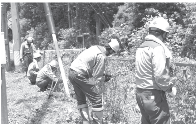
▲関西電力の皆さんによる作業の様子
