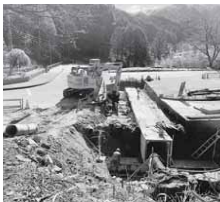
▲ 現在工事中の延沢
