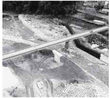
▲建設が進む和村橋
