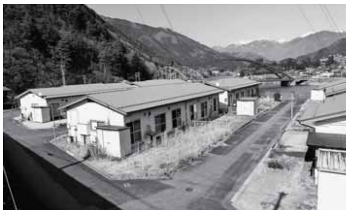
村営住宅 阿寺団地
