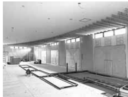
工事が進む新庁舎（図書館）
