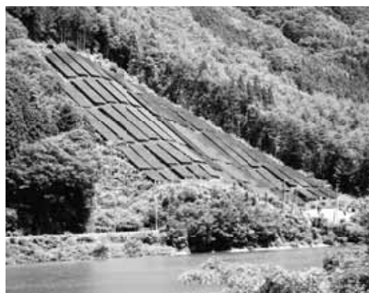
川向地区の太陽光パネル
