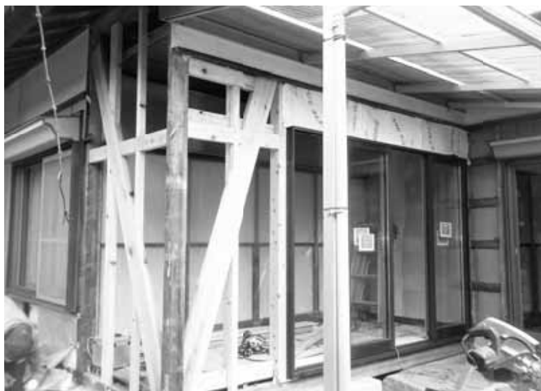
住宅耐震補強工事
