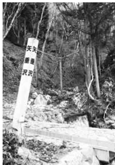
矢垂沢砂防緊急対策事業 (ワイヤーネット)
