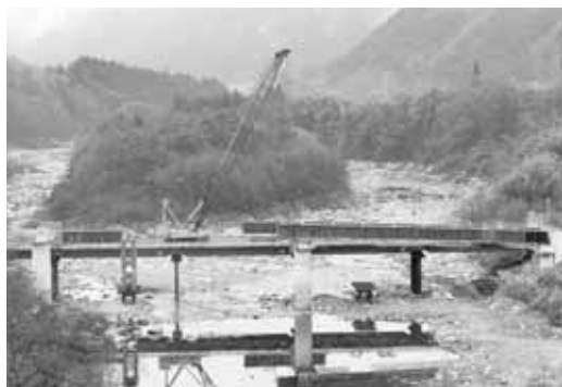
上部工の架設工事が進む大桑橋
