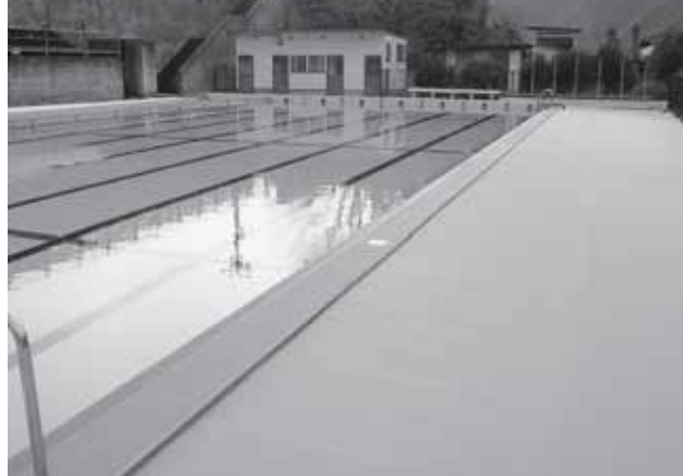
大桑小学校プール改修事業
