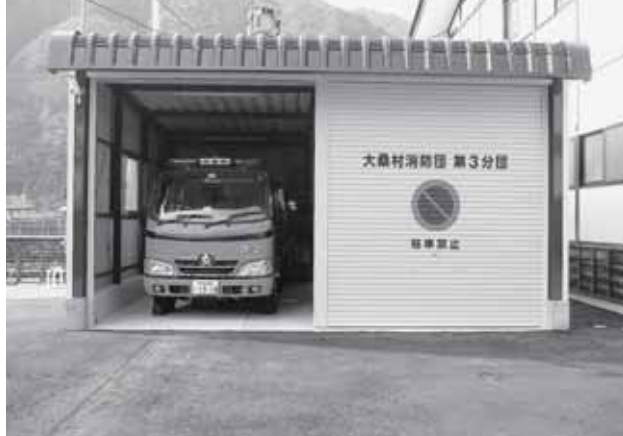
消防団第3分団ポンプ車庫建築事業
