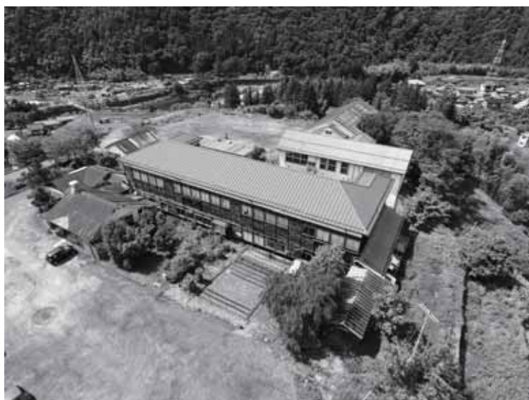
解体予定の旧大桑小学校
