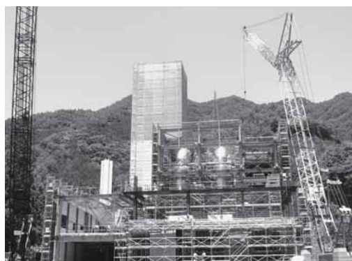
新炉建設状況 7月7日
