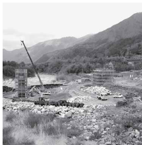
大桑橋橋脚工事
