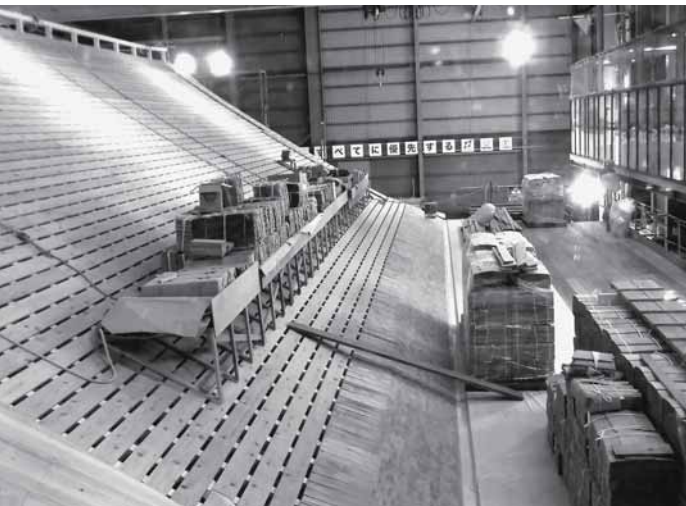
▲本丸御殿復元工事（柿葺き屋根） ▼スマートモビリティパーク
