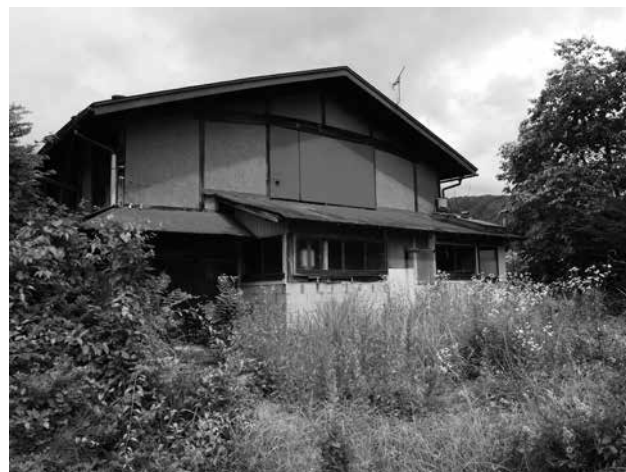
和村にある空き家
