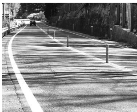
国道19号のセンターポール
