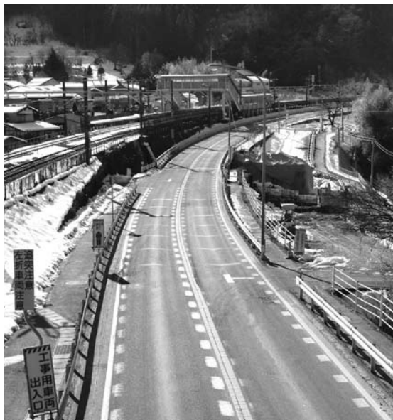
改良工事が進む国道19号
