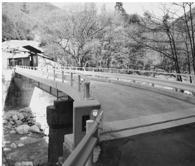
修繕後の伊奈川橋（田光）
