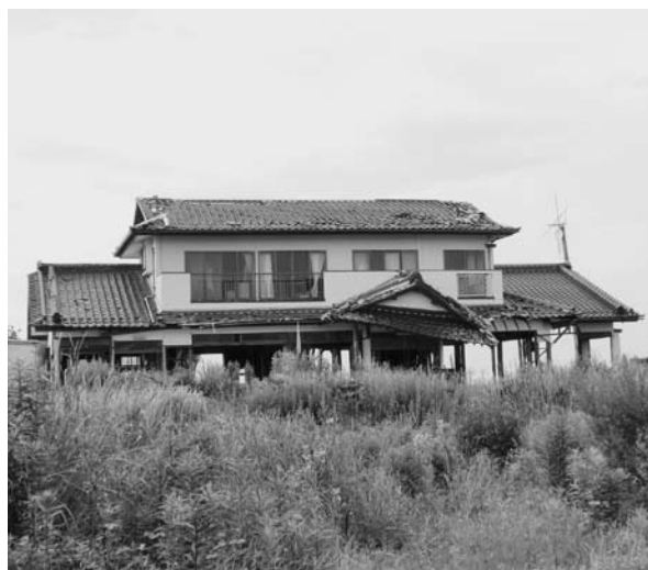
被災した住宅 (H25.7.10 南相馬市)
