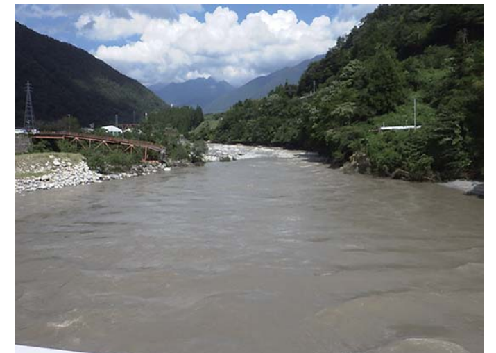
平成30年 台風21号による大桑橋落橋
