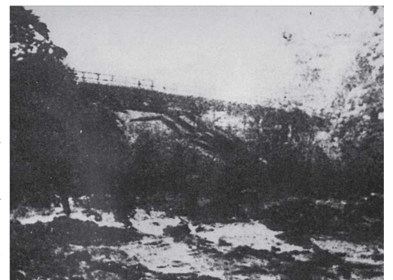
橋げたが折れた伊奈川橋(大正12年7月18日)
