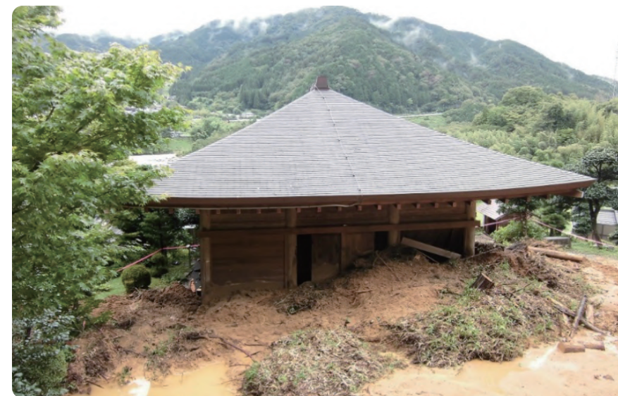
▲ 被災直後の池口寺薬師堂（令和3年8月15日）
