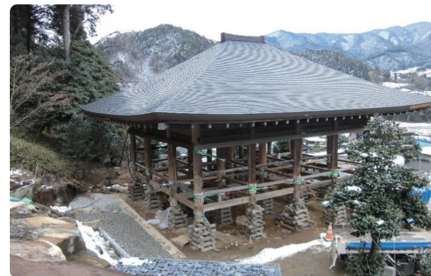
▲ 修復中の池口寺薬師堂（令和4年12月現在）
