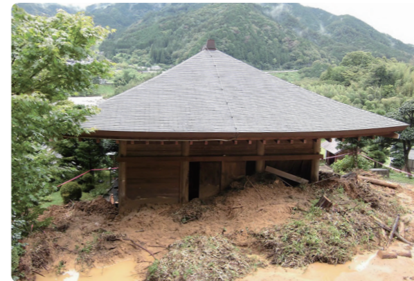
〈被災直後の池口寺薬師堂〉
