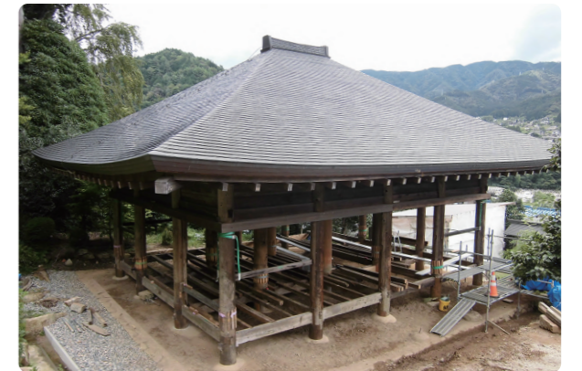
〈修復中の池口寺薬師堂〉 (令和5年8月現在)
